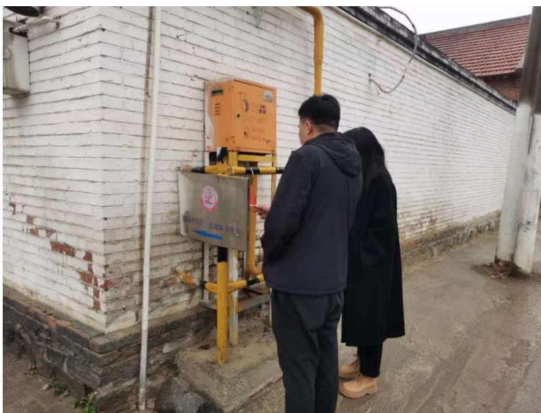
图 3—2 驻村书记检修天然气管道
